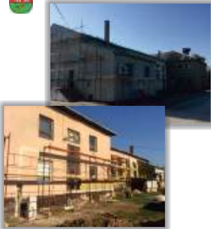
Obecný úrad ČOLTOVO (aktuálny stav rekonštrukcie)
