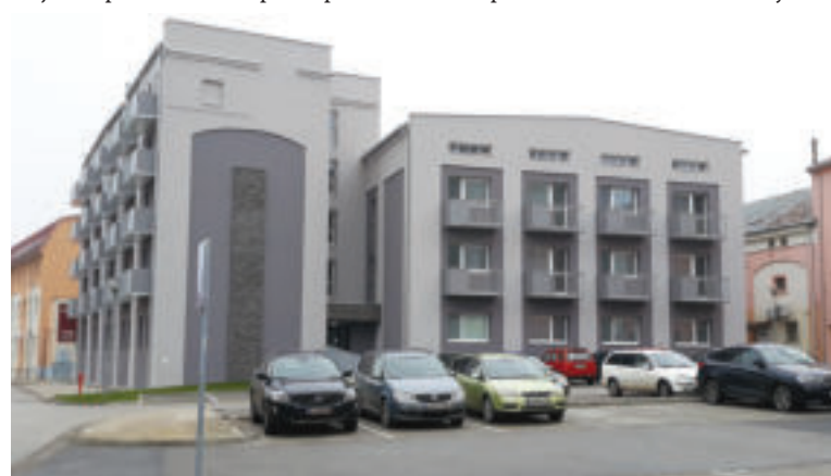
City dom vznikol vďaka komplexnej rekonštrukcii takmer 150 rokov starého objektu.
