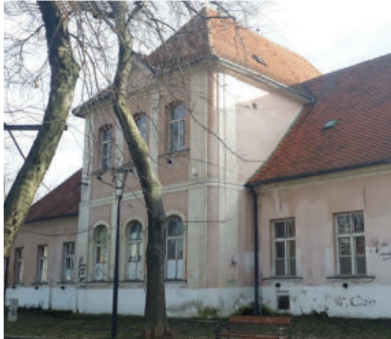
Emmerovu vilu čaká rekonštrukcia.
