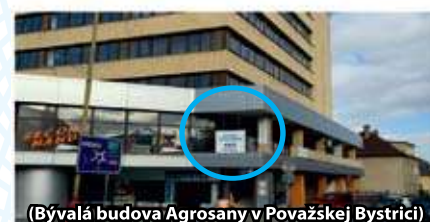
(Bývalá budova Agrosany v Považskej Bystrici)
