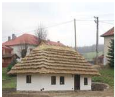
Obnovená chalúпка či „Domček Deduška Večerníčka“. zdroj foto: KPÚ Prešov Nová Sedlica, foto A. Liška
