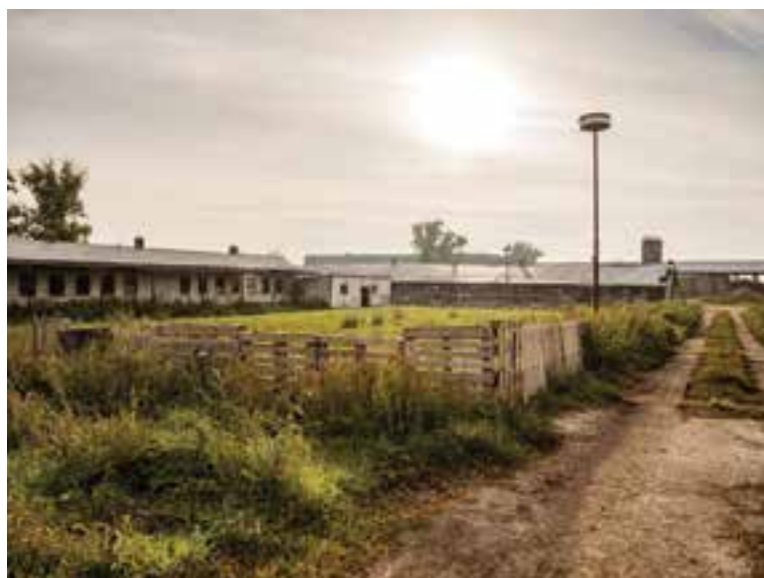
Areál bývalého školského hospodárstva na Zavarskej.
