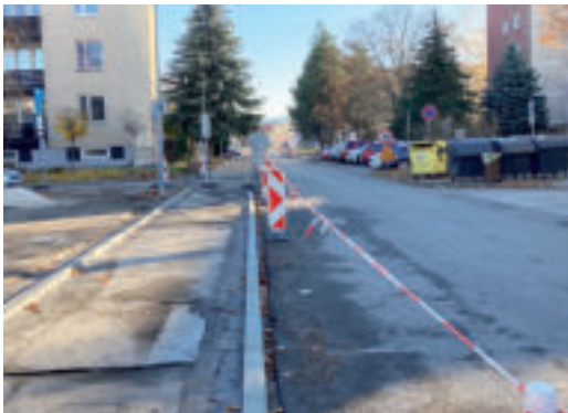
V centre mesta sú realizované práce na Ul. M. Mišíka.
