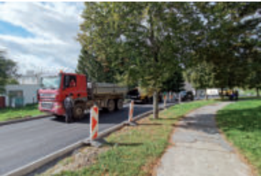
Na sídlisku Kopanice bola najväčšou investíciou rekonštrukcia Ul. energetikov.
