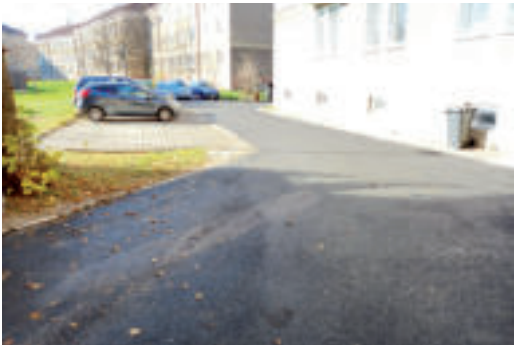
Opráv sa dočkala aj poškodená miestna komunikácia vo vnútrobloku na Svätoplukovej ulici.
