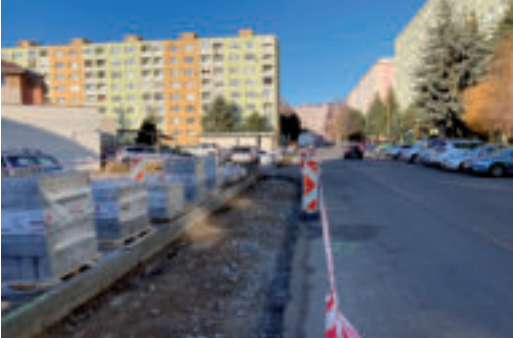
Práve realizované práce na oprave chodníka na Ulici M. Rázusa.
