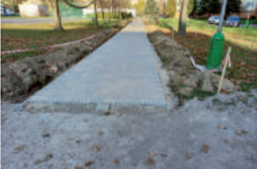
Práce na chodníku Ul. E. M. Šoltésovej sú pred dokončením.
