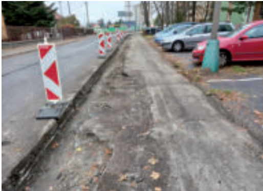
Práce na opravách chodníka na Ulici stavbárov.
