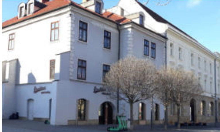
Budovu Prachárne čaká revitalizácia.
