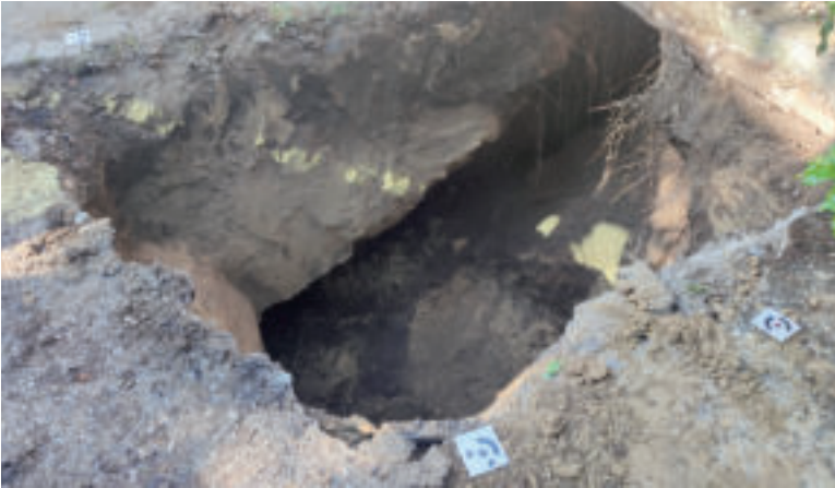
Loch s prepadnutým stropom. zdroj: SAHI, o. z., foto: A. Fónod
