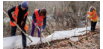
Inštalácia dočasných migračných zábran pre obojživelníky. autor foto M. Hrešová
