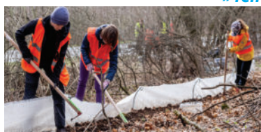
Inštalácia dočasných migračných zábran pre obojživelníky. autor foto M. Hrešová
